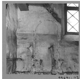
113 Ikkunan oviaukea ruokohuoneen pohjoispuolelta linat-pöytä
