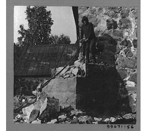
52 Raaskolaukkaan kottareforin purkutyö
