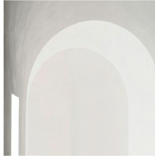
Uudisosan sisäseinät, Silikaattipohjainen hiertopinta
